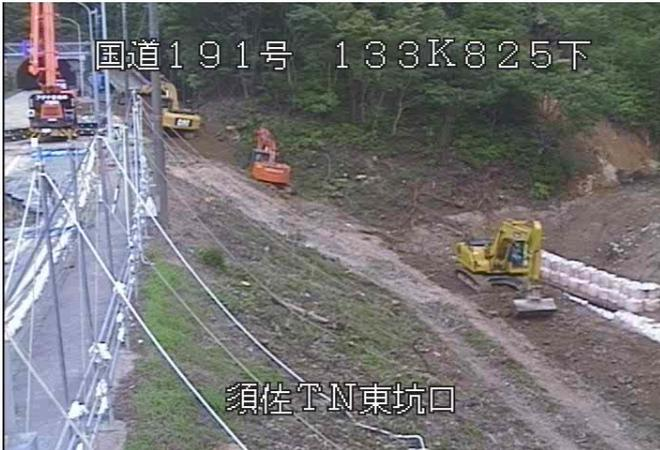
迂回路盛土のための基盤を作る工事を行っています。
