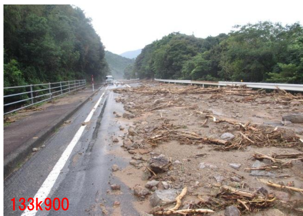
下り線法面崩落: 上下線通行止め
