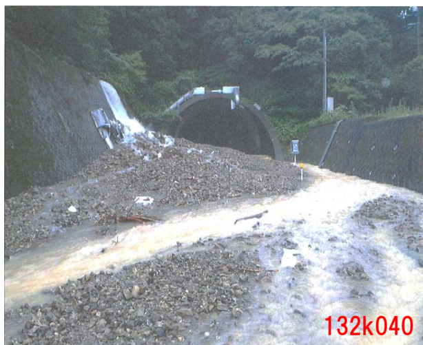
土砂流出: 上下線通行止め(大刈トンネル)
