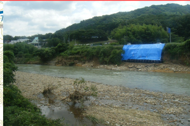
7/31 崩落部土のう及びブルーシート設置完了
