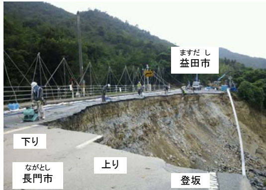
平成25年8月1日 14:00撮影 復旧作業状況
