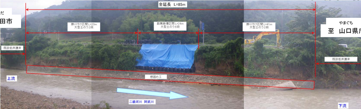
7/31 崩落部土のう及びブルーシート設置完了
