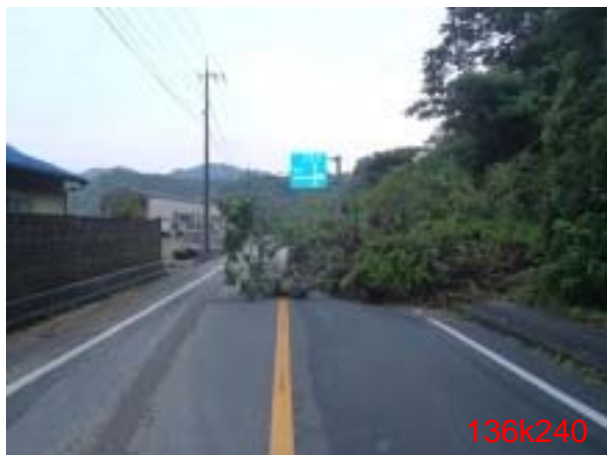
法面崩壊・倒木:上下線通行止め
