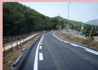
国道191号(萩市須佐) 通行可能 (8月4日 16:00撮影)
