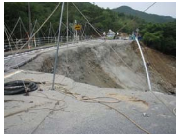
平成25年8月2日 11:00撮影 崩落部モルタル吹き付け
