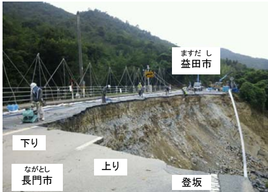
平成25年8月1日 14:00撮影 復旧作業状況
