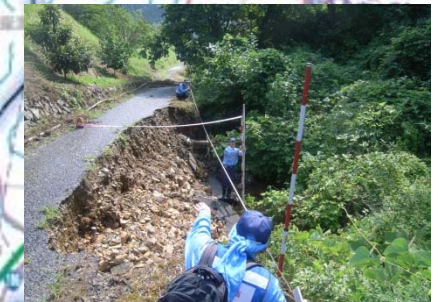
早期の災害復旧に向けた調査 【島根県津和野町(町道)】
