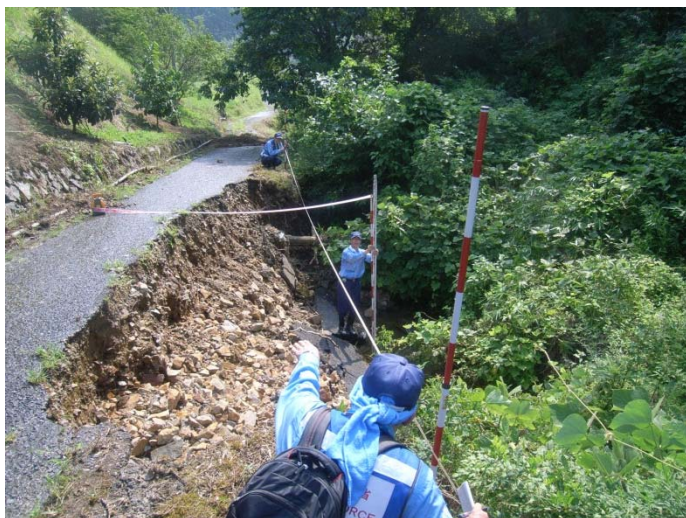
道路班 被災状況調査
