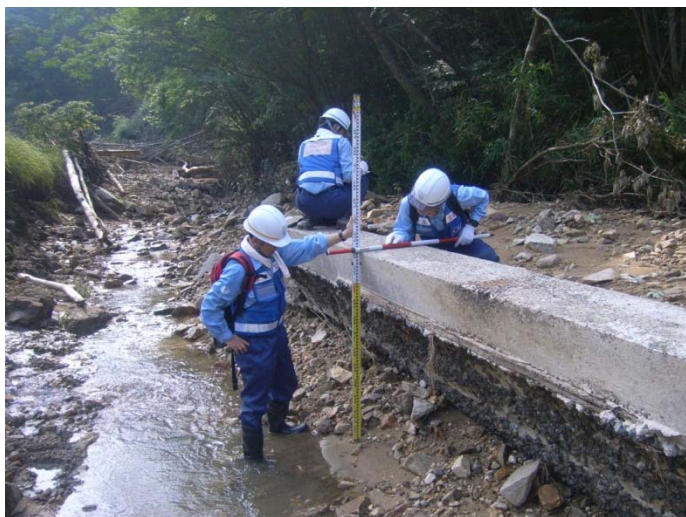
河川班 被災状況調査
