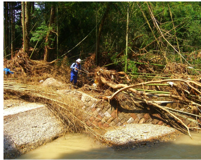
河川班 被災状況調査
