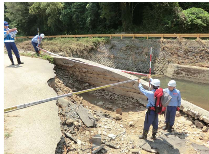
砂防班 被災箇所での現地調査
