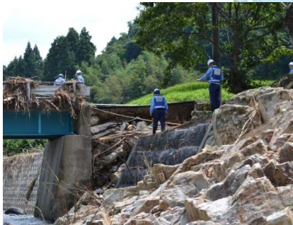
早期の災害復旧に向けた調査 【山口県萩市(被災橋梁の調査)】
