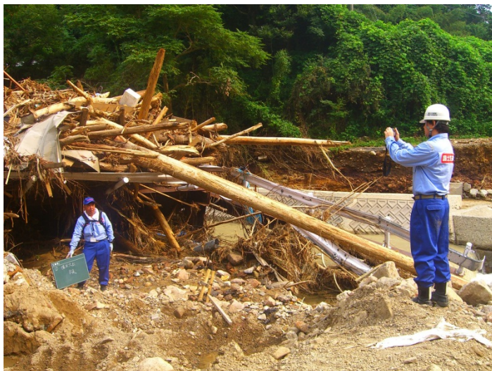
河川班 被災状況調査
