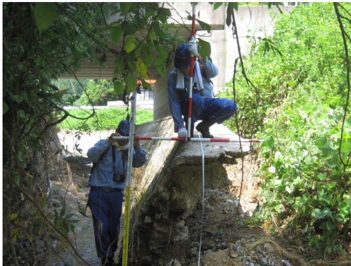
河川班 被災箇所での現地調査
