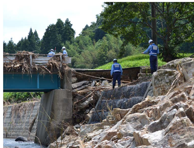
現地支援班 被災状況調査
