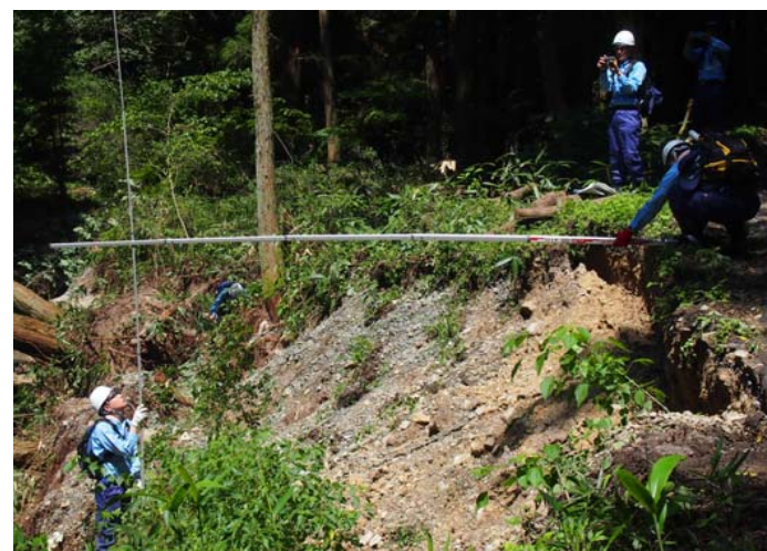
道路班 被災箇所での現地調査(江津市 小田井沢線)
