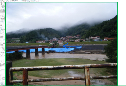
江の川水系濁川(護岸にシート張完了)
