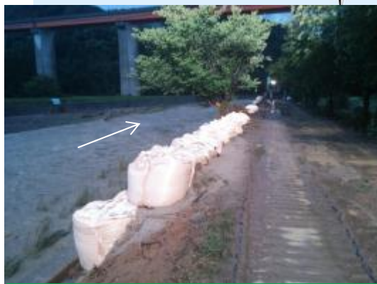
敬川水系敬川(応急復旧状況)
