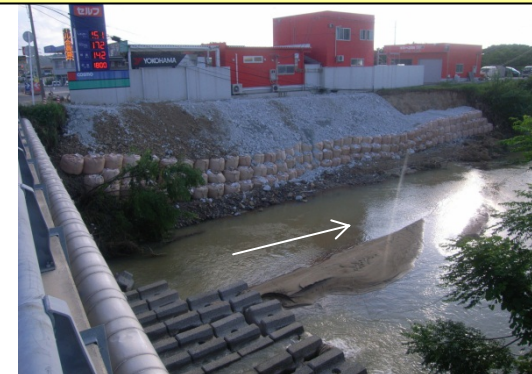
水尻川水系水尻川(応急復旧完成)
