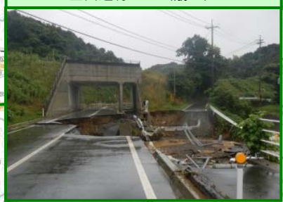
あといちはしていしゃじょうせん 浜田市波子町 跡市波子停車場線 浜田市波子町 全面通行止め (崩土)
