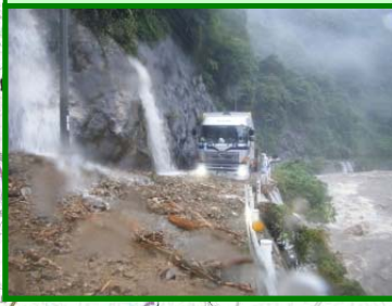
たどこころくさせん 田所国府線 全面通行止め (崩土) 8/27 15:00解除
