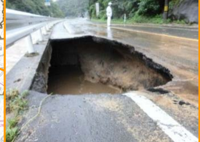
国道261号 おおなんちょういばら 全面通行止め (路面陥没) 8/25 19:00片交
