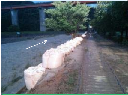
うやがわ うやがわ 敬川水系敬川(応急復旧状況)
