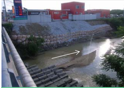
すいじりがわ すいじりがわ 水尻川水系水尻川(応急復旧完成)
