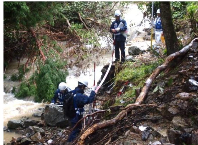
道路班による被災状況調査(沢津川線)
