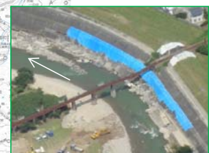
江の川水系濁川(護岸にシート張完了)
