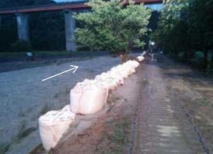
敬川水系敬川(応急復旧状況)
