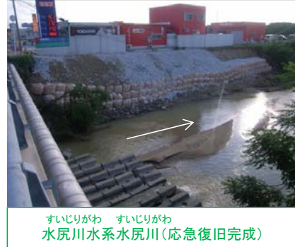
水尻川水系水尻川(応急復旧完成)
