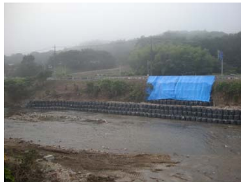
8/10 崩落部土のう及びブルーシート設置完了
