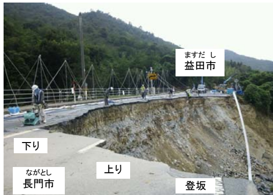
平成25年8月1日 14:00撮影 復旧作業状況
