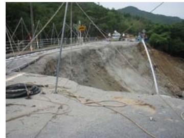
平成25年8月2日 11:00撮影 崩落部モルタル吹き付け
