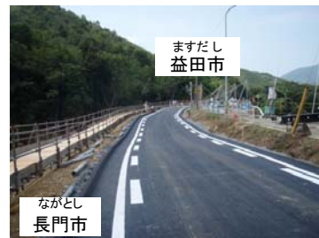
平成25年8月4日 15:00撮影 迂回路舗装工事等
