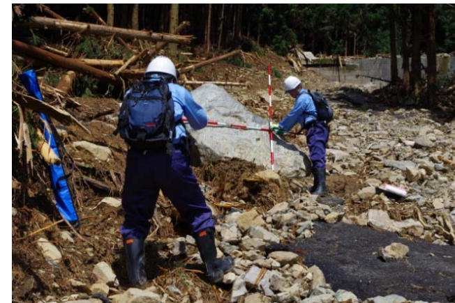
●不安定土塊の調査状況
