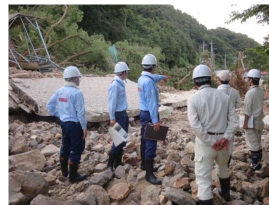
●道路班 被災箇所の事前調査
