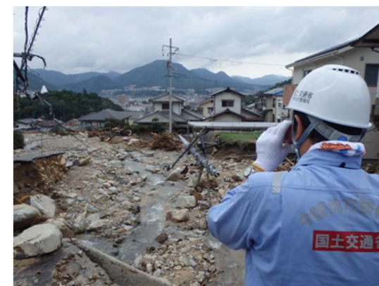
河川班 新建川での被災状況調査
