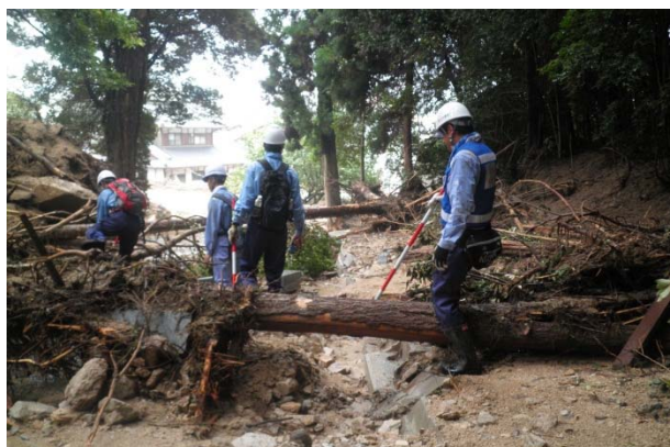
被災状況調査
