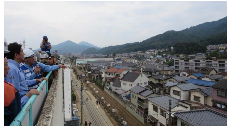
現地調整所リエゾン(高橋技術調整管理官)による TEC-FORCE活動状況の報告
