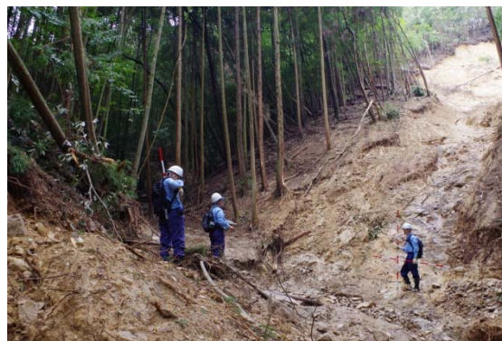
土砂災害の調査状況
