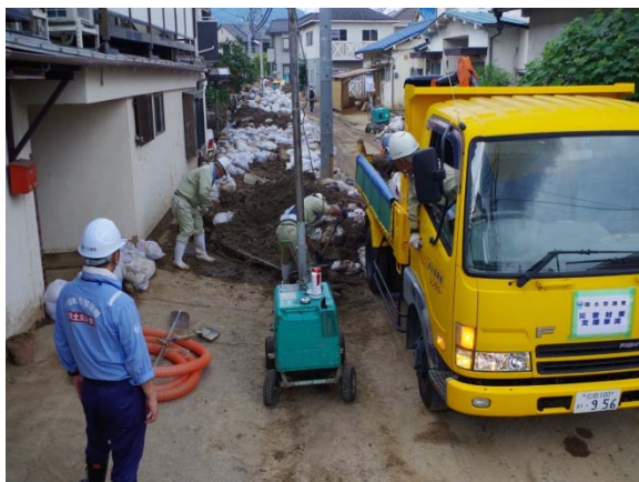
堆積土撤去状況
