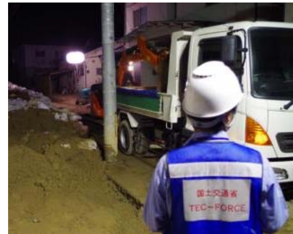
堆積土撤去状況(夜間)
