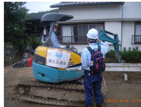
堆積土撤去状況
