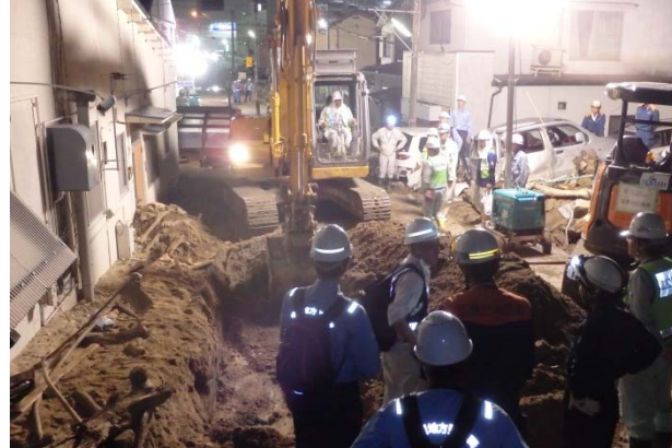
堆積土砂の撤去状況（夜間）
