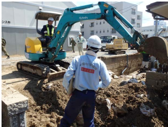
堆積土砂の撤去状況
