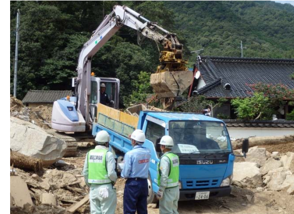
堆積土砂の撤去状況
