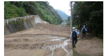
被災状況の調査（道路班） 【H26.8広島豪雨災害】
