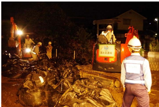
堆積土砂撤去の作業状況 (夜間)
