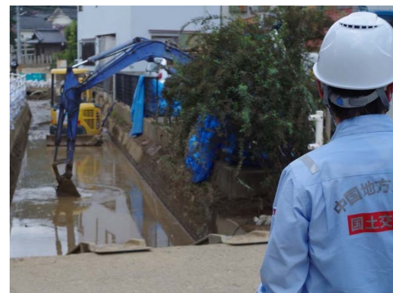
堆積土砂の撤去状況
