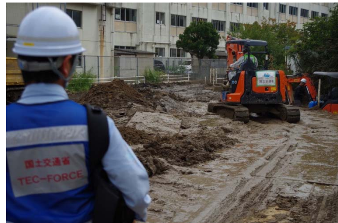
堆積土砂の撤去状況（八木用水） 【安佐南区八木】
