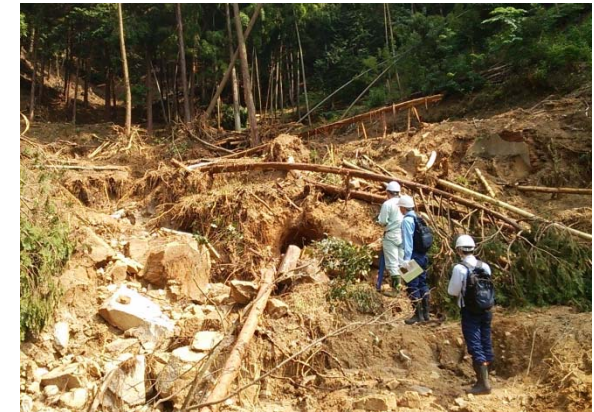
被災調査状況 【安佐北区可部】
