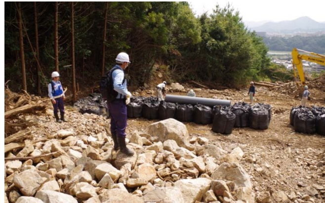
大型土のう設置状況 【安佐南区八木】
