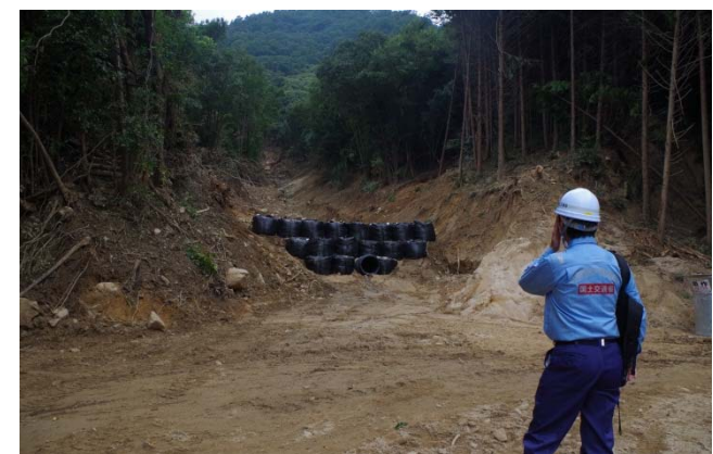
大型土のう設置状況（砂防） 【安佐南区八木】
