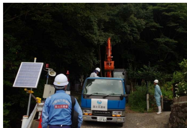
大型土のう設置作業状況（砂防） 【安佐南区八木】
