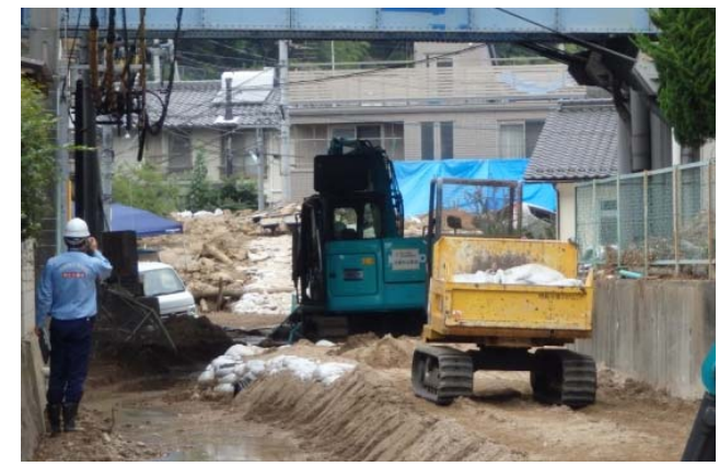
堆積土砂の撤去状況（道路） 【安佐南区八木】
