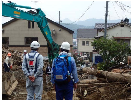
堆積土砂の撤去状況（道路） 【安佐南区緑井】
