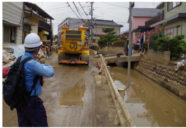
八木用水の通水機能の確保（水路） 【安佐南区八木】
