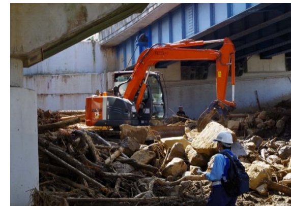
堆積土砂の撤去状況 【安佐南区八木】
