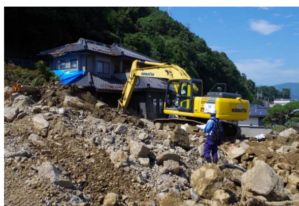
堆積土砂の撤去状況 【安佐南区八木】
