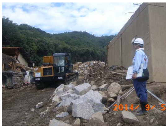
堆積土砂の撤去状況 【安佐南区八木】
