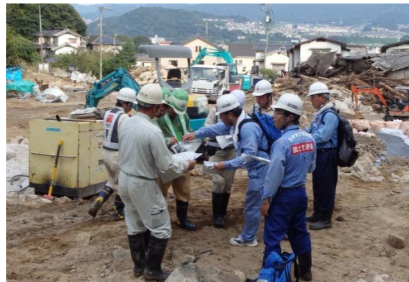
協力業者との調整状況 【安佐南区緑井】
