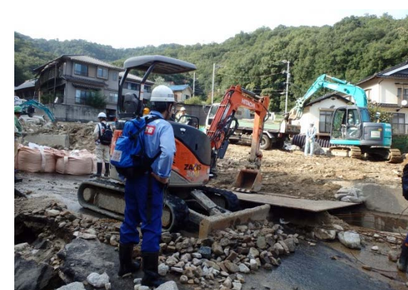
堆積土砂の撤去状況 【安佐南区緑井】
