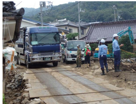
堆積土砂の撤去状況 【安佐南区八木】
