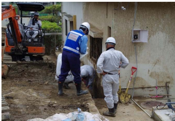
堆積土砂の撤去状況 【安佐南区八木】
