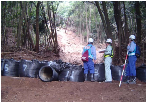
大型土のう設置状況 【安佐南区緑井】
