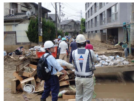
堆積土砂の撤去に関する調整 【安佐南区八木】
