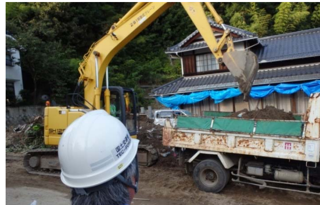
堆積土砂の撤去状況 【安佐南区緑井】
