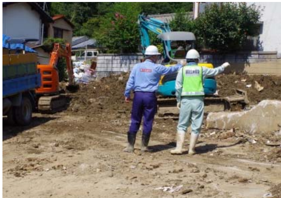
協力業者との調整状況
