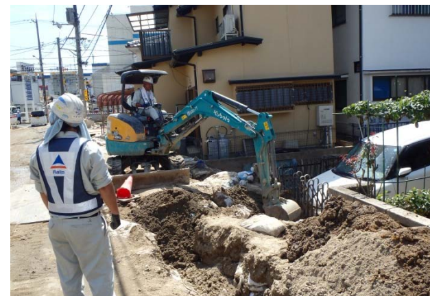
堆積土砂の撤去状況 【安佐南区八木】
