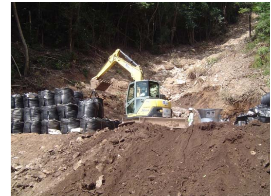
大型土のう設置状況 【安佐南区八木】
