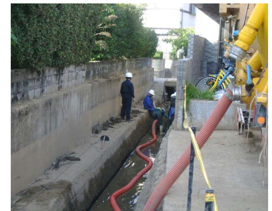
堆積土砂の撤去状況 【安佐南区八木】
