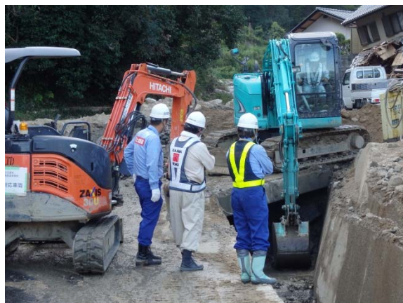
堆積土砂の撤去状況 【安佐南区緑井】
