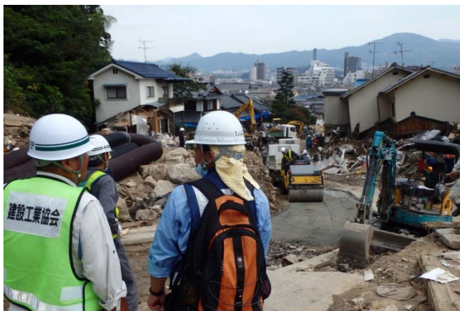
協力業者との調整状況
