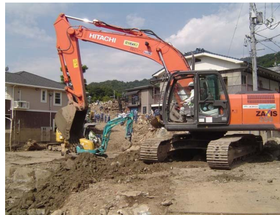
堆積土砂の撤去状況 【安佐南区八木】
