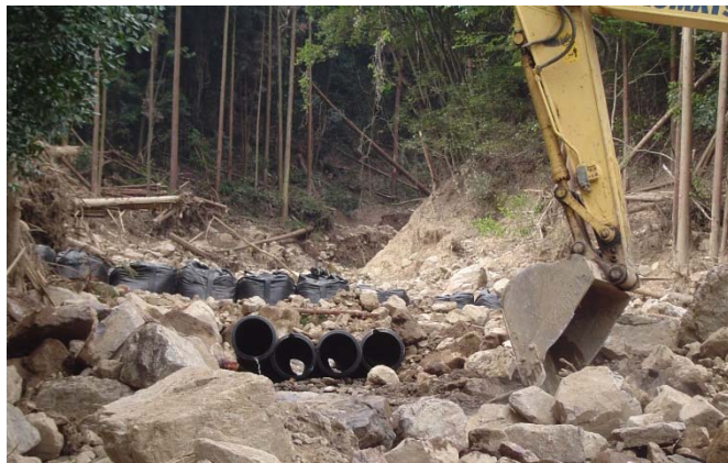
大型土のうの設置作業状況 【安佐南区八木】
