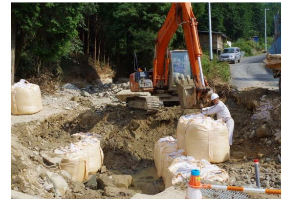
大型土のう設置作業状況 【安佐北区可部東】
