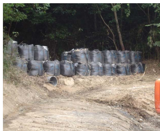
大型土のうの設置状況 【安佐南区八木】
