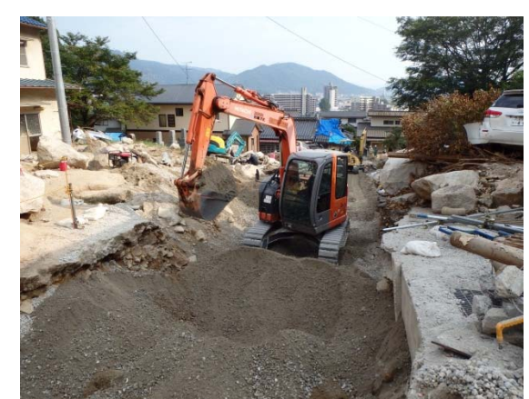
堆積土砂の撤去状況 【安佐南区緑井】
