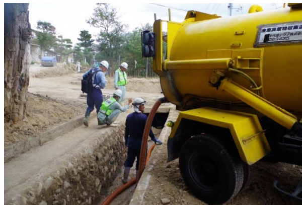
水路の堆積土砂撤去状況 【安佐南区八木】
