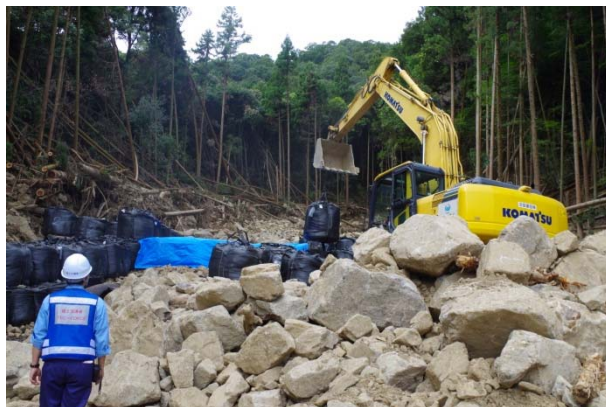
大型土のう設置状況 【安佐南区八木】
