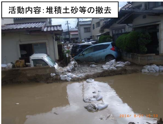
8月27日 土砂等撤去前 【安佐南区八木3丁目】
