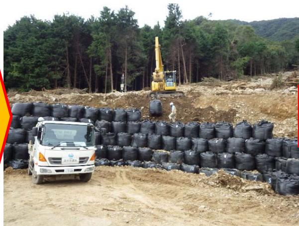
大型土のう設置作業中
