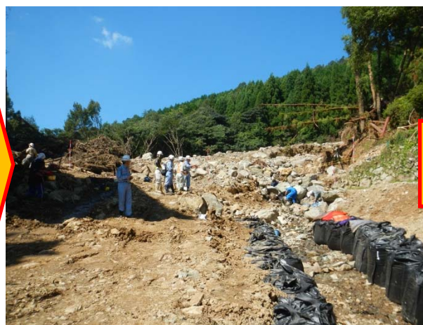
大型土のう設置作業中 【安佐南区八木4丁目】
