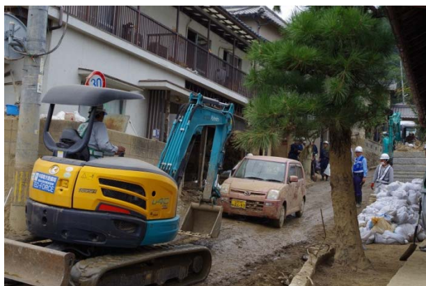
堆積土砂等の撤去状況 【安佐南区八木3丁目】
