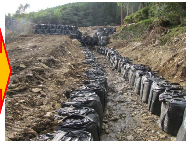
大型土のう設置後 【安佐南区八木4丁目】
