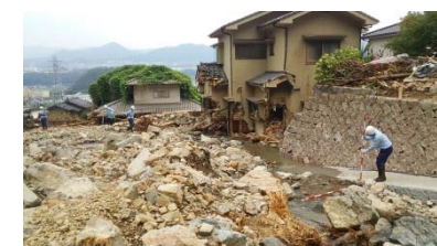
被災状況の調査 【H26.8広島豪雨災害】
