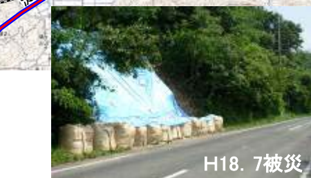
⑦ 迂回路の状況 (大雨による被災箇所)
