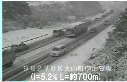
③ 国道9号縦断線形不良箇所
