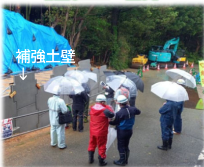
補強土壁の前側
