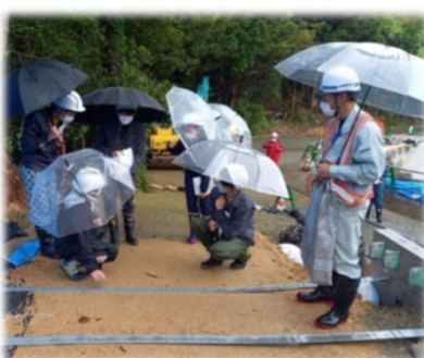
補強土壁の裏側のしくみ
