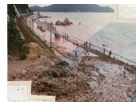
【写真②】S55被災状況
