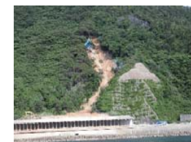
【写真①】H23被災状況
