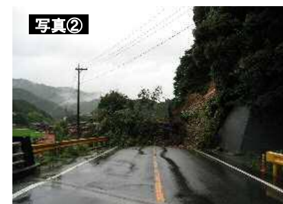
▲ 国道316号における被災状況 (通行止め：4日間) (H22.7.14長門市湯本四ノ瀬)
