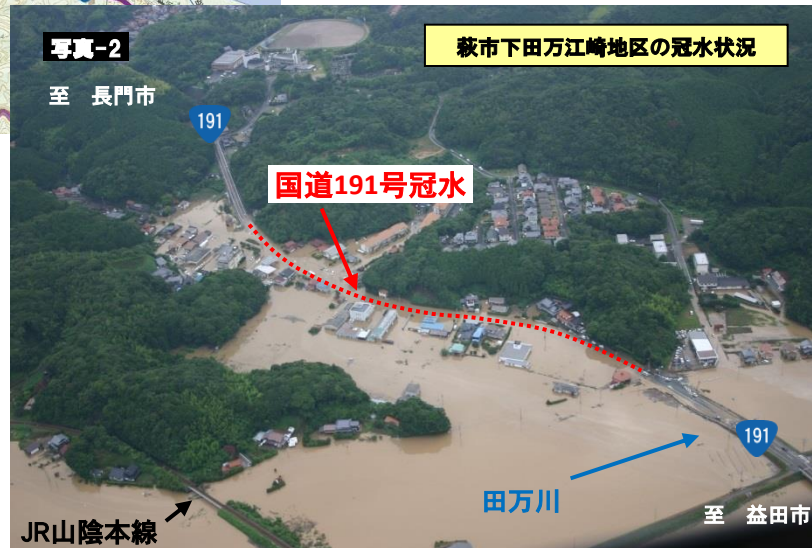
▲被災状況 (H25.7.28)
