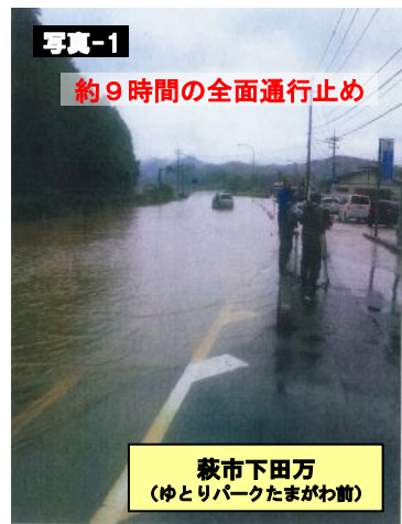
▲被災状況 (H25.7.28)
