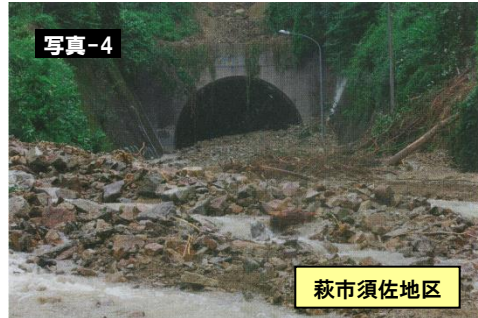
▲ 国道315号金山谷トンネル (H25.7.28)
