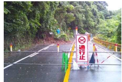
▲通行止め状況
