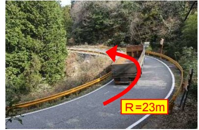
▲平面線形不良箇所
