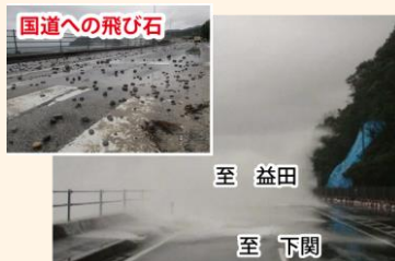
国道191号の越波状況
