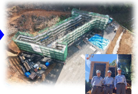
③下関市豊田町金道地区内 工事名：金道地区第7改良工事(別紙-3参照)
