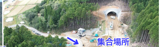
第1トンネルL=278m(施工中)
