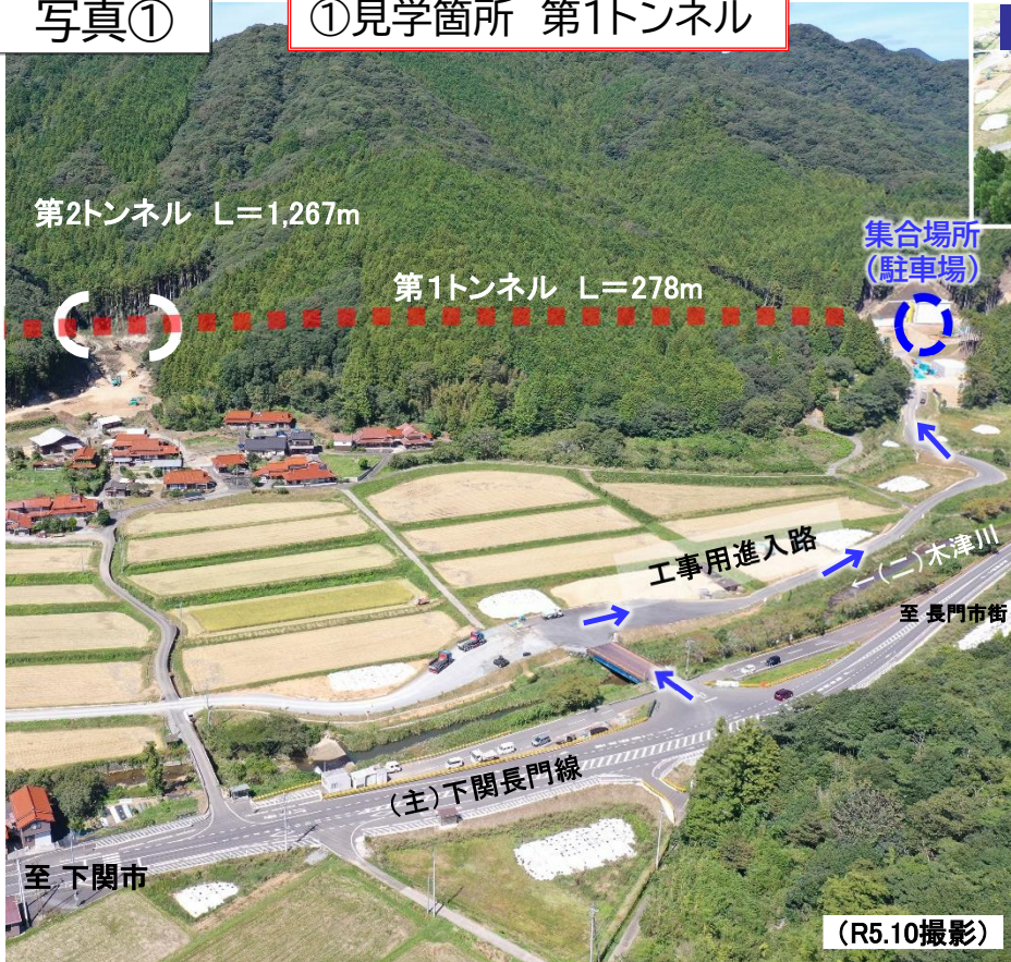
第1トンネルL=278m(施工中)
