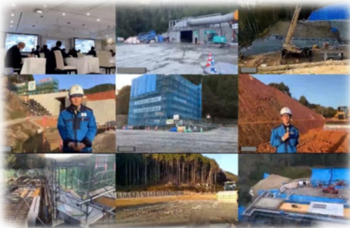
工事現場との中継映像
