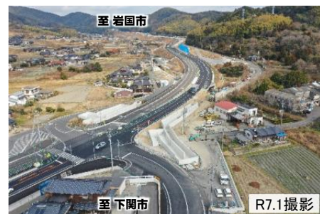
【写真②】富海交差点付近の施工状況
