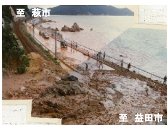
【写真②】S55年土砂崩壊の状況
