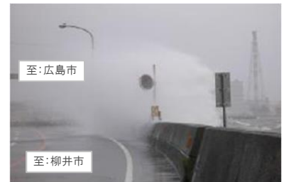
【写真①】越波の状況
