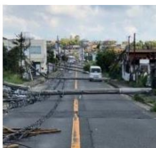
＜電柱の倒壊による道路閉塞の事例＞
