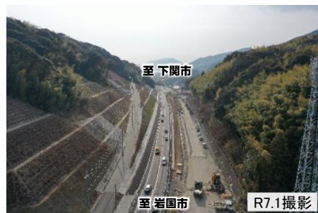
【写真①】樺地区の法面施工状況
