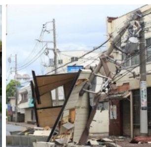
＜飛来物による電柱倒壊の事例＞
