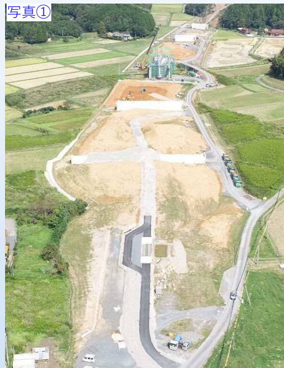
写真① 豊田IC(仮称)より北を望む 上八道第4改良工事状況
