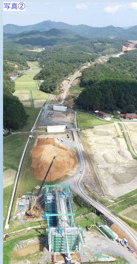
写真② 栗野川より北を望む 栗野川橋PC上部工事状況
