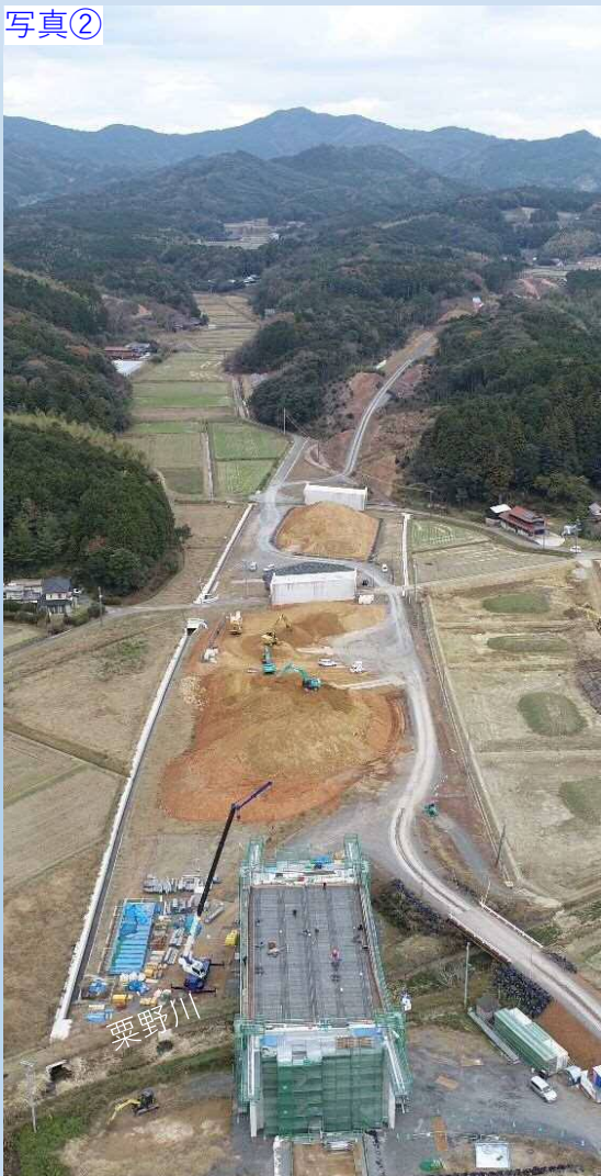
栗野川より北を望む 栗野川橋PC上部工事 状況
