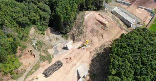
金道地区第11改良工事[R8.7月末時点] 至 下関市
