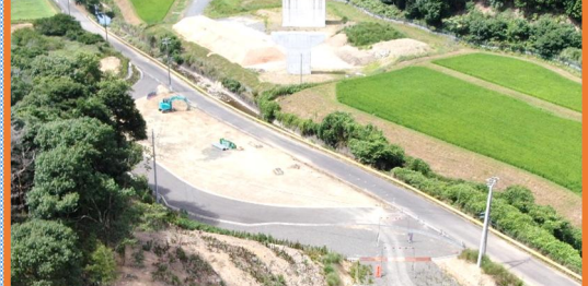
稲見川橋第2下部工事[R8.7月末時点] 至 長門市
