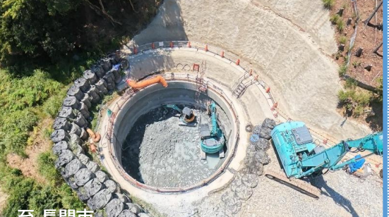
木津川橋第1・2下部工事[R8.7月末時点] 至 長門市
