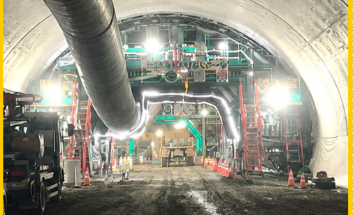
第2トンネル工事[R8.7月末時点] 至 長門市
