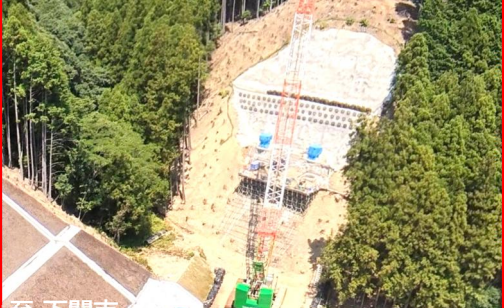
木津川橋第1下部工事[R8.7月末時点] 至 下関市
