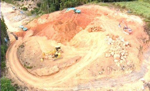
稲見地区第8改良工事[R8.7月末時点] 至 下関市
