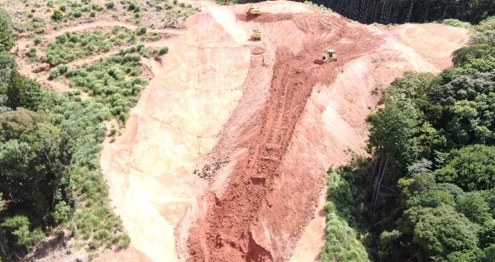
稲見地区第6改良工事[R8.7月末時点] 至 下関市
