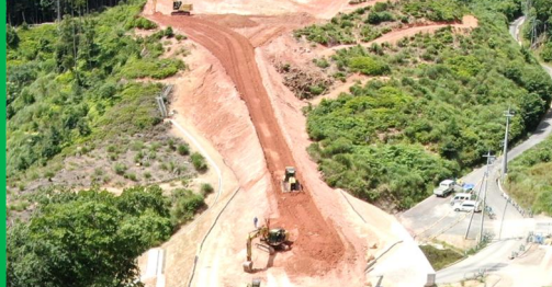
稲見地区第7改良工事[R8.7月末時点] 至 長門市
