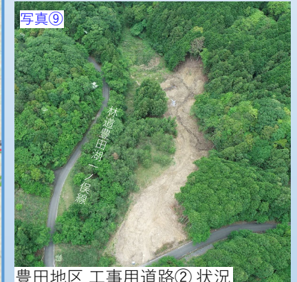
写真⑨ 豊田地区 工事用道路② 状況
