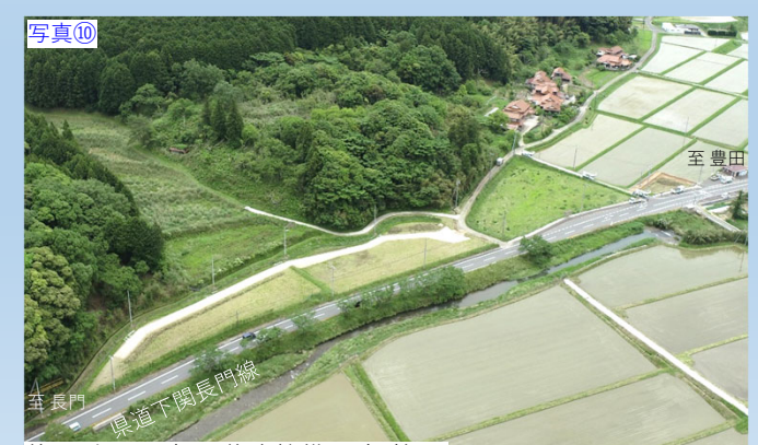
写真⑩ 俵山地区工事用道路整備工事 状況
