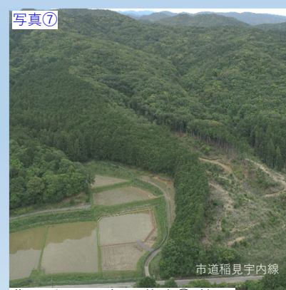
写真⑦ 豊田地区 工事用道路④ 状況
