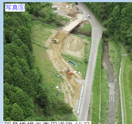
写真⑤ 稲見橋横工事用道路 状況
