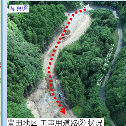
写真⑨ 豊田地区 工事用道路② 状況
