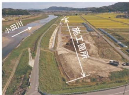
小田川堤防強化工事(服部地区)
