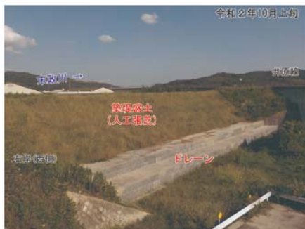
末政川堤防強化工事(有井地区)
