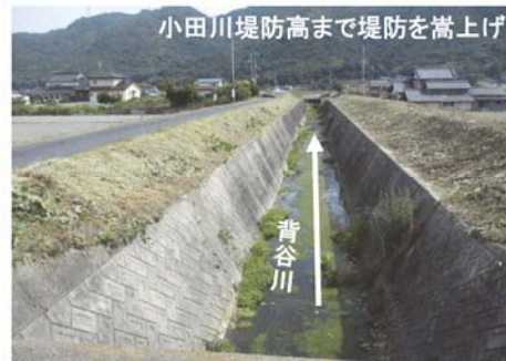
背谷川堤防嵩上工事
