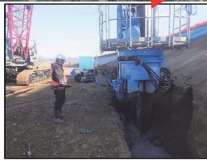
有井・川辺地区基盤漏水対策では矢板の打ち込み中。
