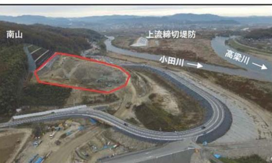
南山掘削工事は、山頂（標高76m）から約35m掘削が完了し、法面を安定させるためにアンカーワークを施工しています。その他の工事の順調に進捗しています。
