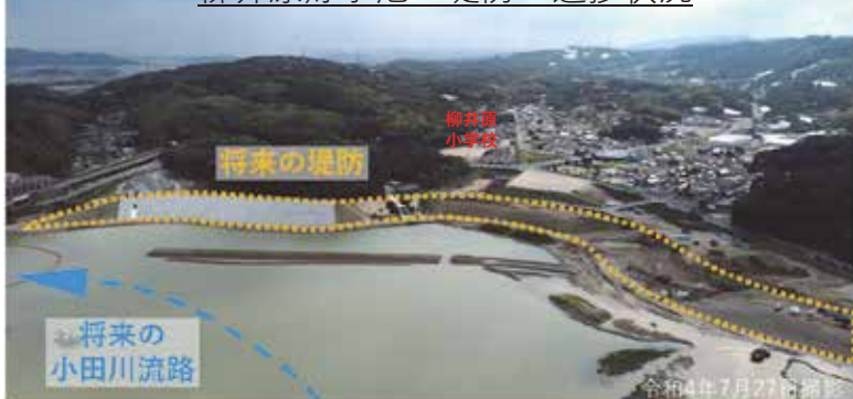
柳井原貯水池の堤防の進捗状況
